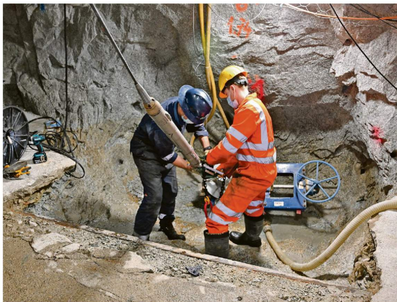
Wissenschaftler installieren im Bedretto-Stollen eine Seismometerkette im Bohrloch zur Überwachung der Stimulationen. Foto: FO
