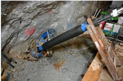
Installation von Packern zur Isolierung der Stimulationsintervalle im Bohrloch ST2 im Bedretto-Labor der ETH Zürich. Die Arbeiten wurden unter der Leitung von Geo-Energie Suisse durchgeführt. © Geo-Energie Suisse
