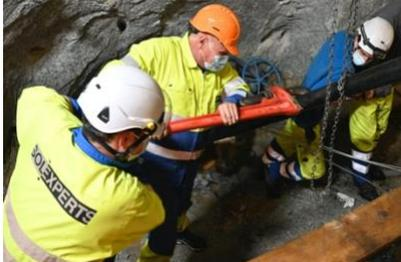
Installation von Packern zur Isolierung der Stimulationsintervalle im Bohrloch ST2 im Bedretto-Labor der ETH Zürich. Die Arbeiten wurden unter der Leitung von Geo-Energie Suisse durchgeführt. © Geo-Energie Suisse
