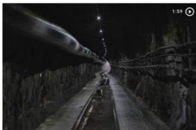
Das Video zeigt die Öffnung des Bohrlochs ST1 in einer Tiefe von 265 (von 400) Metern. Die Wasserdurchlässigkeit der wasserführenden Klüfte (Transmissivität) steigt sichtbar an: Trotz drei aktivierten Saugpumpen wird der Bohrlochkeller überflutet. © Geo-Energie Suisse
